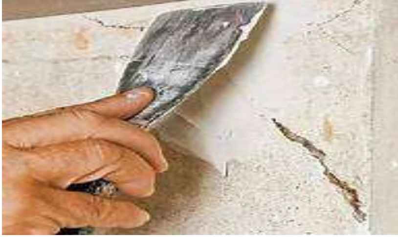
الشكل رقم (٢٩) يوضح عملية معالجة الشقوق
