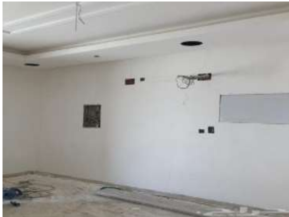
الشكل رقم ( ١٠ ) يوضح عملية الانتهاء من تجهيز السطح للصق
