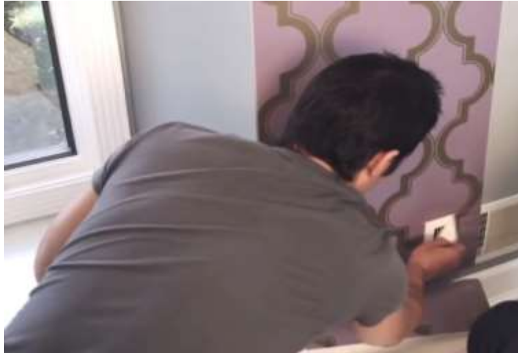
الشكل رقم ( ٥٢ ) عملية فتح فتحات الزوائد يوضح
