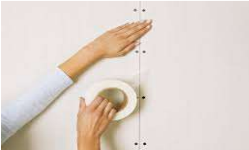
الشكل رقم ( ٣٧ ) يوضح عملية معالجة الشروخ
