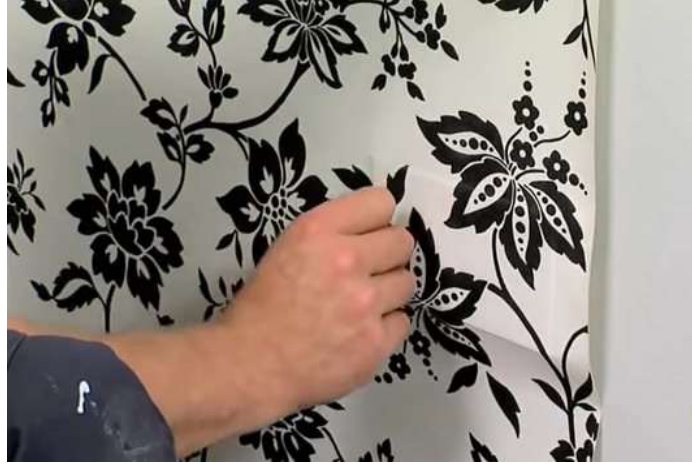
الشكل رقم (٢٤) وضع الشرائح بجانب بعضها وكي الفواصل
