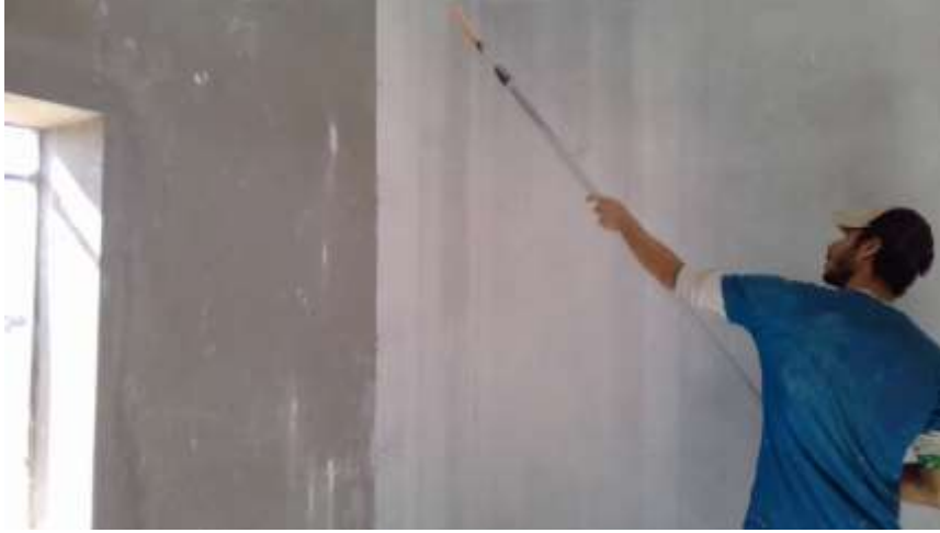
الشكل رقم (٣٦) يوضح الشكل عملية تجهيز السطح لعملية اللصق
