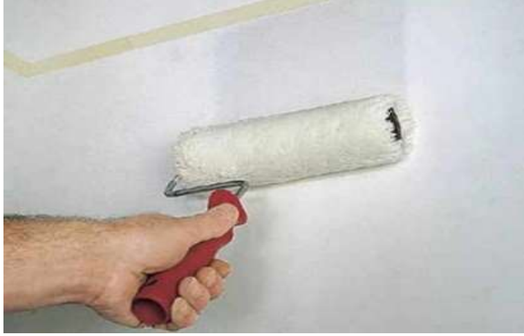
الشكل رقم ( ١٨ ) يوضح عملية دهان الحائط بالمادة اللاصقة
