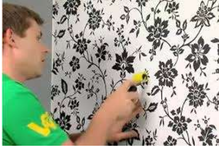
الشكل رقم (٢٤) وضع الشرائح بجانب بعضها وكي الفواصل
