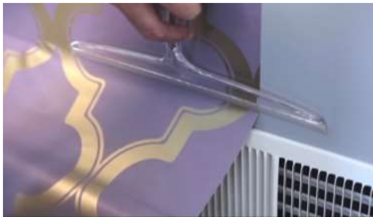
الشكل رقم ( ٤٩ ) يوضح فرد الورق عند الفتحات
