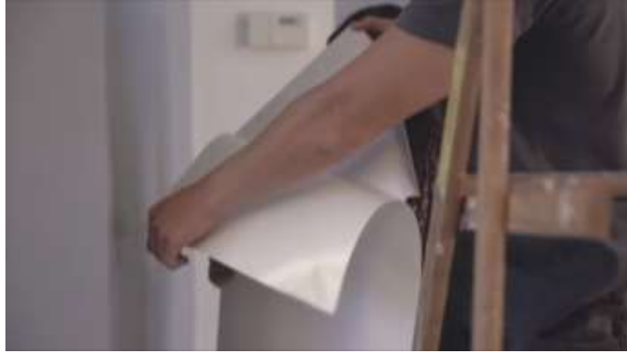
الشكل رقم ( ٤٢ ) يوضح نزع ورق الفنيل ذو اللصق الذاتي
