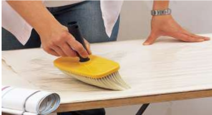
الشكل رقم ( ٤٣ ) يوضح دهان المادة اللاصقة علي الورق
