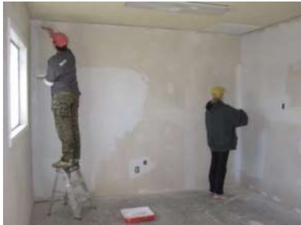
الشكل رقم (٩) يوضح عملية اعداد السطح وسد الثقوب والشقوق
