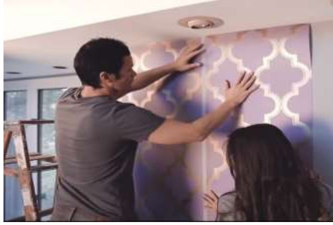
الشكل رقم ( ٤٧ ) يوضح تجميع رسومات الورق علي الحائط
