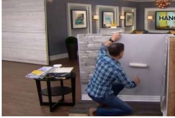
الشكل رقم ( ٤٤ ) يوضح دهان المادة اللاصقة علي الحائط
