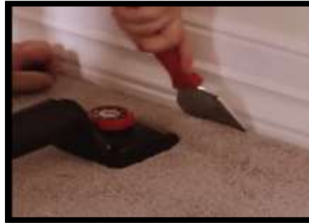
١٢- استخدام ازميل الموكيت فى تشطيب الجوانب
