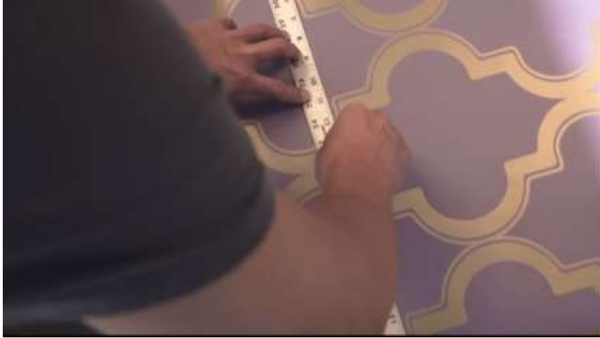
الشكل رقم ( ٣٩ ) يوضح تقسيم الورق بالمقاس المطلوب بواسطة المتر
