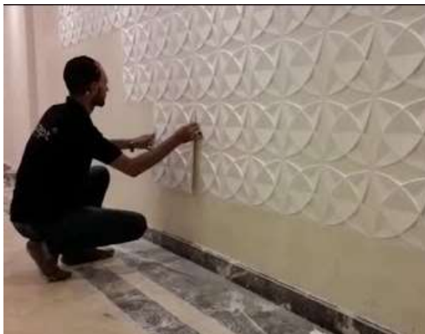
الشكل رقم (٣١) ، (٣٢) يوضحا عملية لصق البلاطات علي الحوائط
