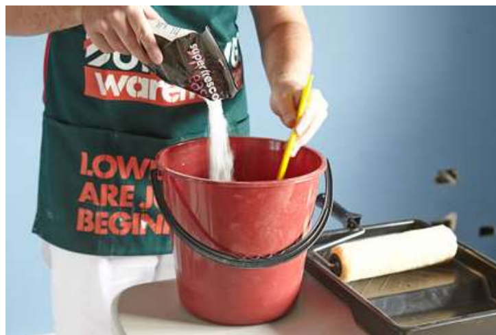
الشكل رقم ( ١٥ ) يوضح عملية اضافة المادة اللاصقة مع التقليب اليدوي
