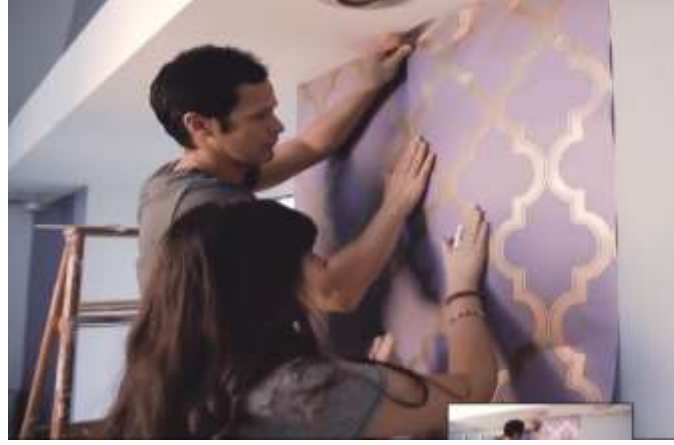
الشكل رقم ( ٤٨ ) يوضح فرد الورق علي الحائط
