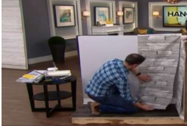
الشكل رقم ( ٤٥ ) يوضح بداية لصق الورق علي الحائط
