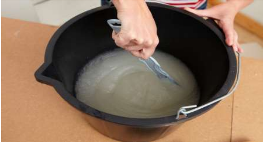
الشكل رقم ( ٤١ ) يوضح تحضير المادة اللاصقة لورق الفينيل سابق التجهيز
