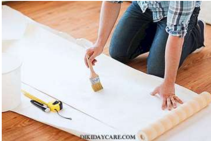
الشكل رقم ( ١٧ ) يوضح عملية دهان الورق بالمادة اللاصقة
