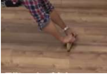
٩- تفريغ الهواء بالراكل
