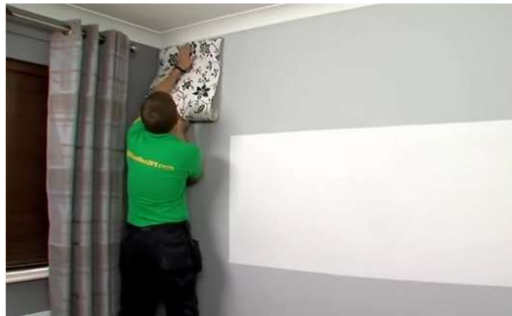
الشكل رقم ( ٢٢ ) يوضح عملية الإمساك بطرفي الورق علي الحائط
