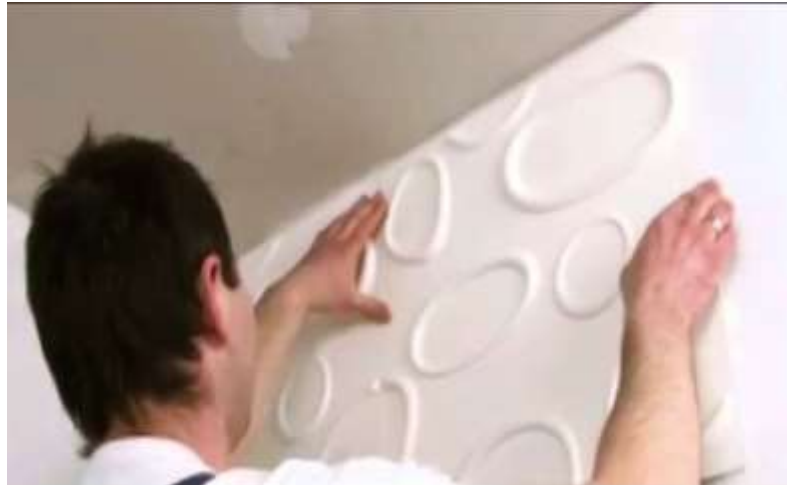
الشكل رقم (٣٠) يوضح عملية التفصيل للبلاطات
