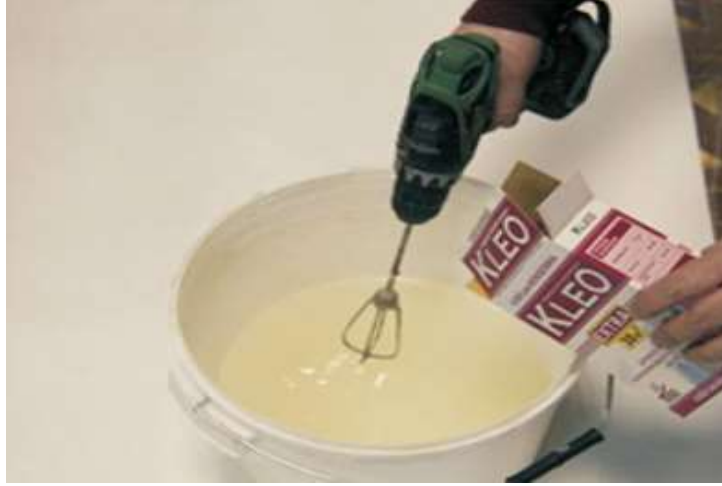
الشكل رقم ( ١٦ ) يوضح عملية تقليب المادة اللاصقة بالشننيور
