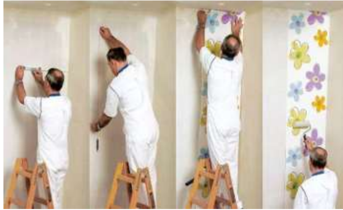
الشكل رقم ( ١٩ ) يوضح عملية بدء عملية التغطية
