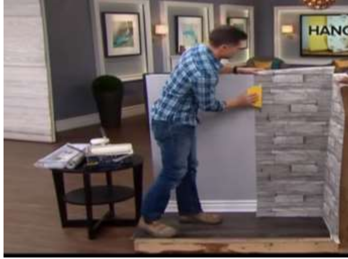
الشكل رقم ( ٤٦ ) يوضح فرد الورق علي الحائط
