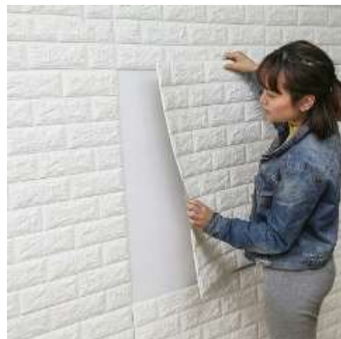
الشكل رقم (٣١) ، (٣٢) يوضحا عملية لصق البلاطات علي الحوائط
