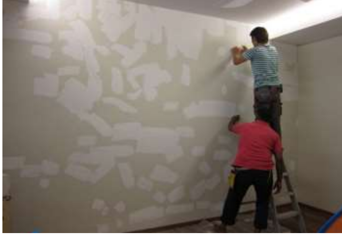
الشكل رقم (٢٧) يوضح عملية تجهيز السطح
