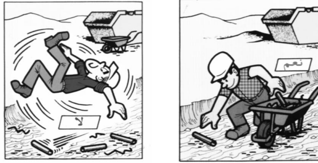
شكل (٢٠) يوضح أهمية إزالة المسامير من الخشب اثناء العمل
