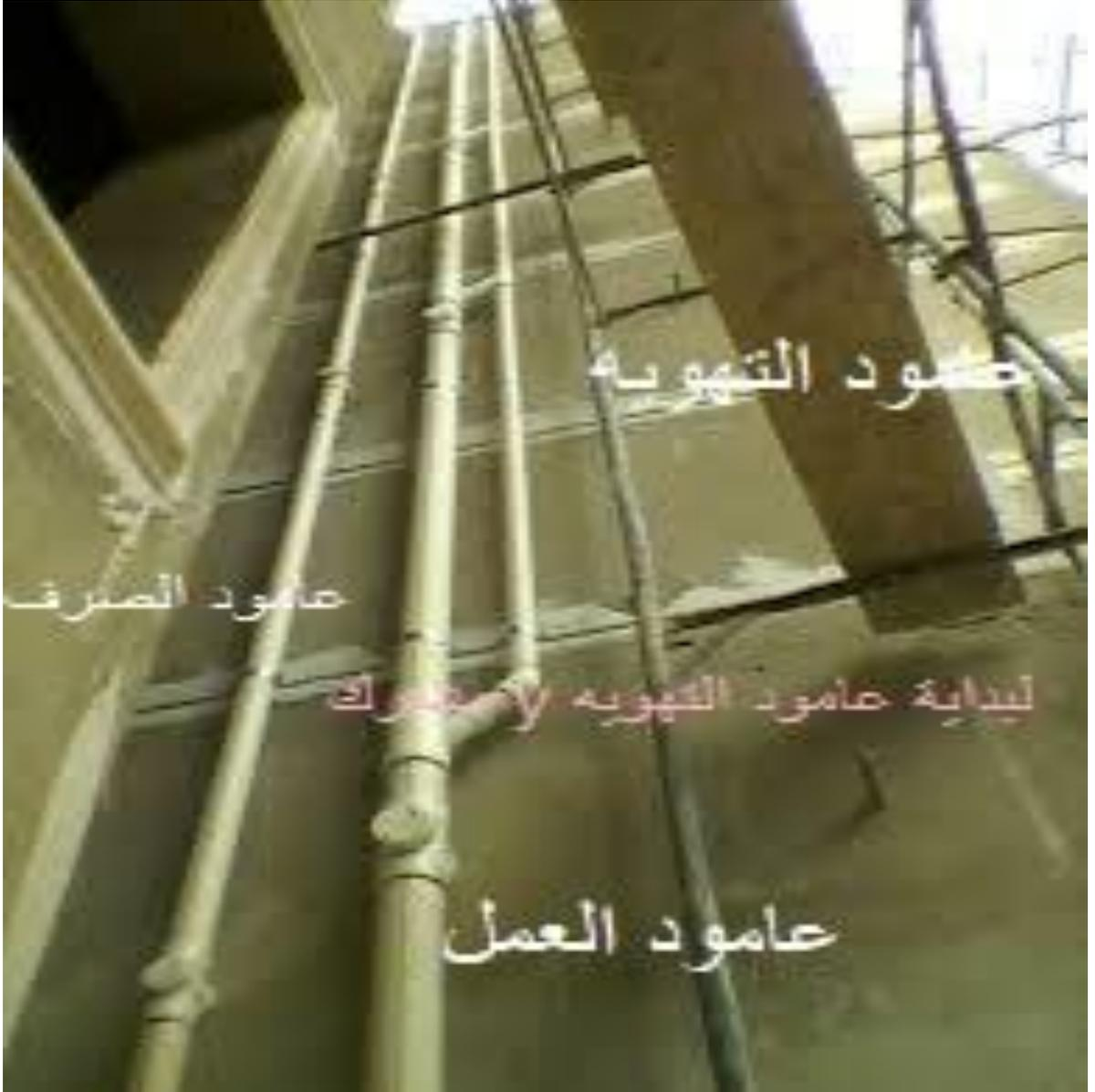
التهوية و طرفها السفلي متصل بعمود العمل ولا يسمح بتدفق مياه الصرف من عمود العمل الى عمود التهوية والشكل رقم ( ١ ) يوضح كيفية توصيل عمود العمل والتهوية
