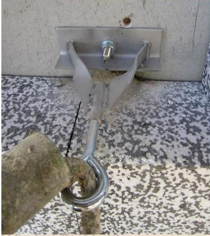
يتم الأخذ بالاعتبار اختيار حجم وقوة المسمار الصلب وان يتحمل قوة جذب للخارج قوة الجذب يجب ألا تقل عن 800 رطل في حالة السقالات الخفيفة ، 1200 رطل في حالة السقالات المتوسطة ، 1600 رطل في حالة السقالات ذات الخدمة الشاقة
