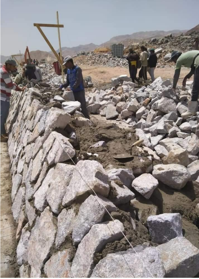
الصورة توضح كيفية ضبط ميول الجسور أو الترع
