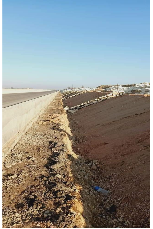
الصورة توضح كيفية ضبط ميول الجسور أو الترع
