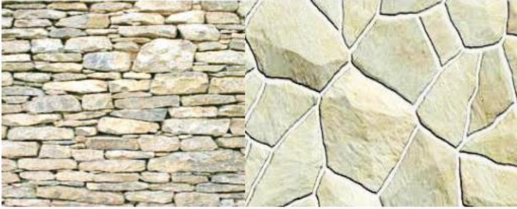
أحجار الدبش المضلع (فلمنشي). أخبار الدبش المبنية في مذاميك مختلفة (مروم).
