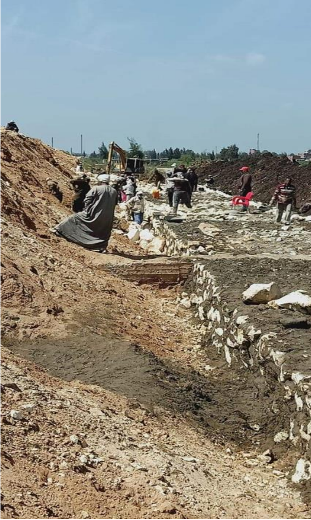
الصورة توضح عمل القدمة في قاع الترعة
