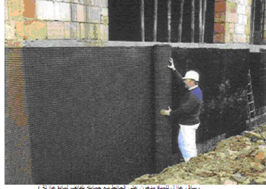
سائل عازل للمياه مدهون على الحائط مع حمايته بملف بلاستيك لعازلة
