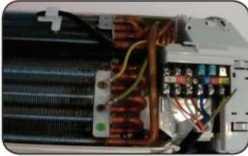
شكل (٢١) موضع حساس درجة حرارة المبخر شكل (٢٢) موضع حساس درجة حرارة الهواء
