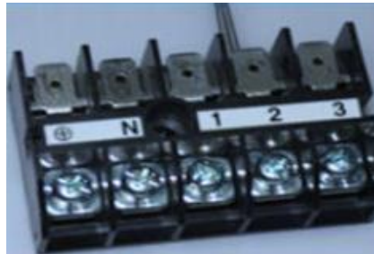
شكل (١٧) يوضح روزته تجميع الوحدة الخارجية بالوحدة الداخلي
