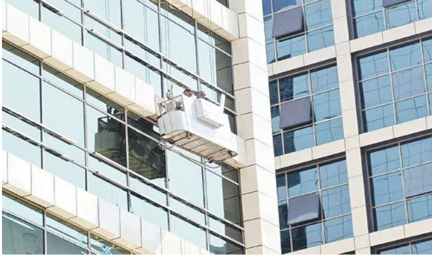
شكل (١٢) يوضح أحد أنواع السقالات المتحركة
